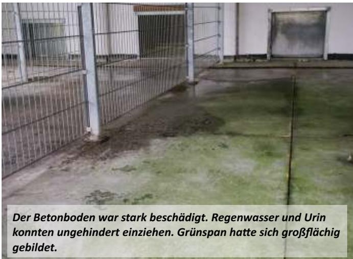
*Der Betonboden war stark beschädigt. Regenwasser und Urin konnten ungehindert einziehen. Grünspan hatte sich großflächig gebildet.*
