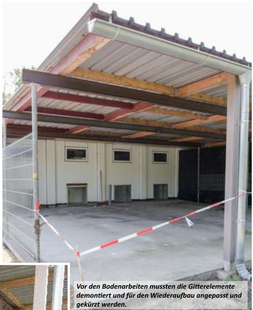
*Vor den Bodenarbeiten mussten die Gitterelemente demontiert und für den Wiederaufbau angepasst und gekürzt werden.*
